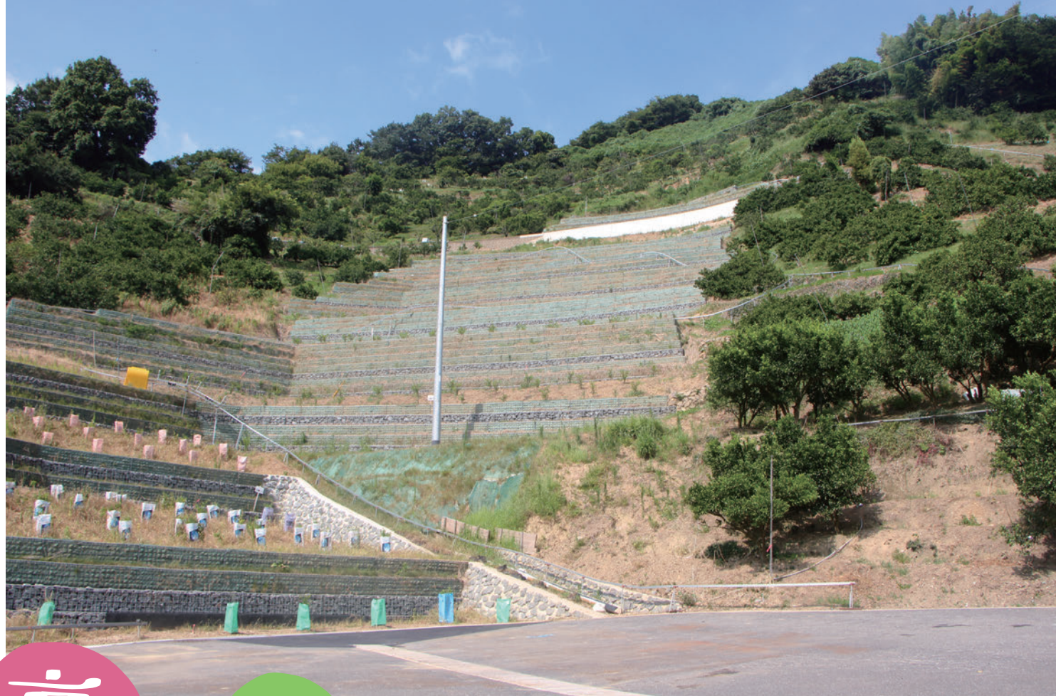
↑ 土砂崩れが発生した場所の現在の様子
