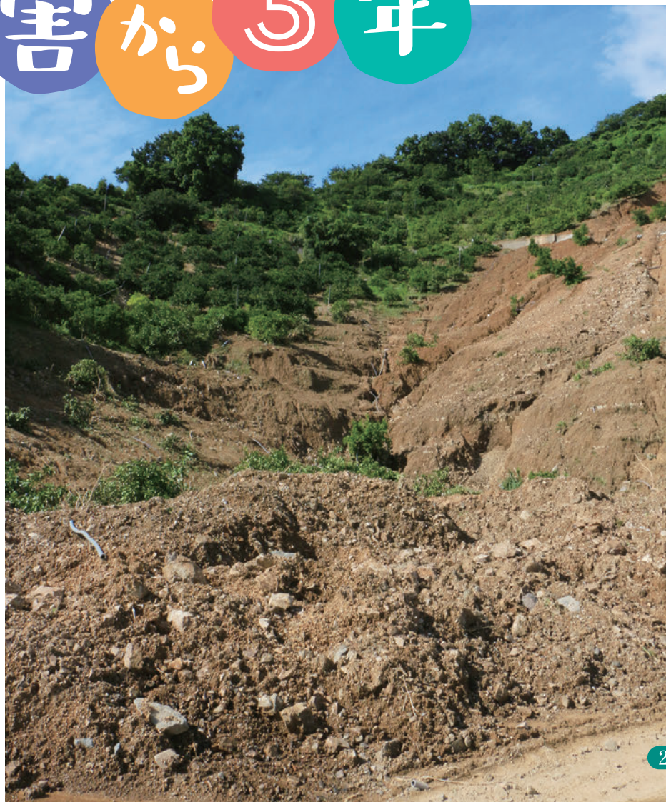
災害発生当時の様子 ↓
