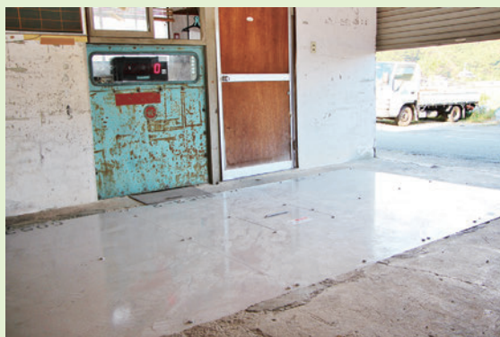
トラックスケール 荷受け作業の効率化を図る
