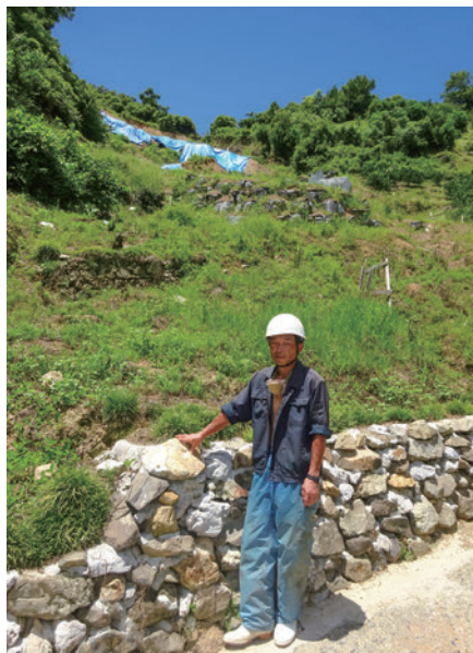
石垣は宮本さんが自分で築いた。後方上部の園地は今から工事が始まる。
